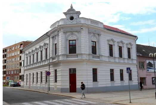
Přerov_rekonstrukce Blažkova domu
